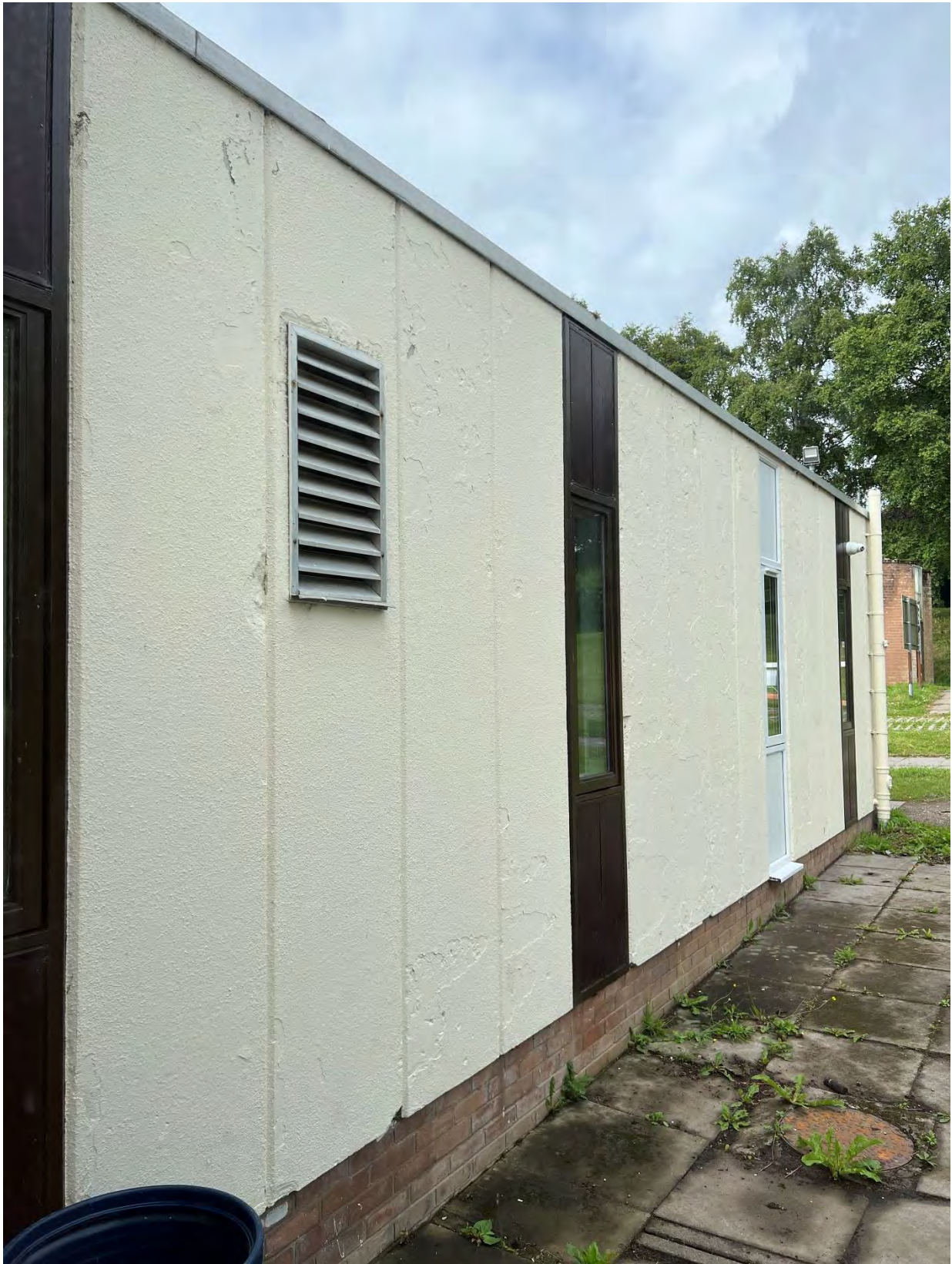
Photo N.18 – External siporex wall panels (kitchen block)
