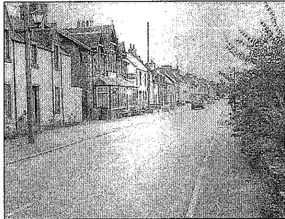
Lairg Road Frontages
