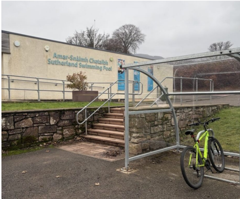
Golspie Leisure Centre, new shelter
